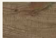
Rauhe Stellen auf der Holzoberfläche
