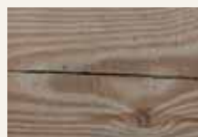
Spannungsrisse durch die Holz-trocknung
