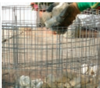
6. Mit Steinen befüllen
